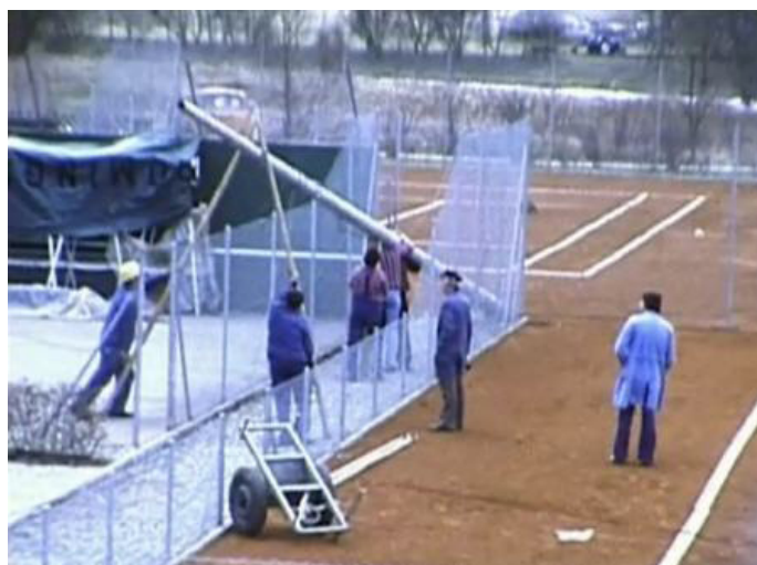
Aufbau der Flutlichtanlage
