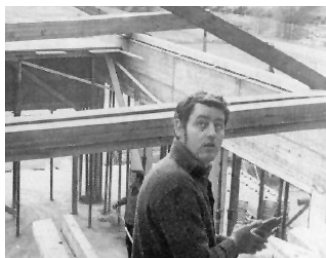
August „Gulle“ Dannegger (Vorstand 1976-84) bei den Bauarbeiten am neuen Clubhaus.
